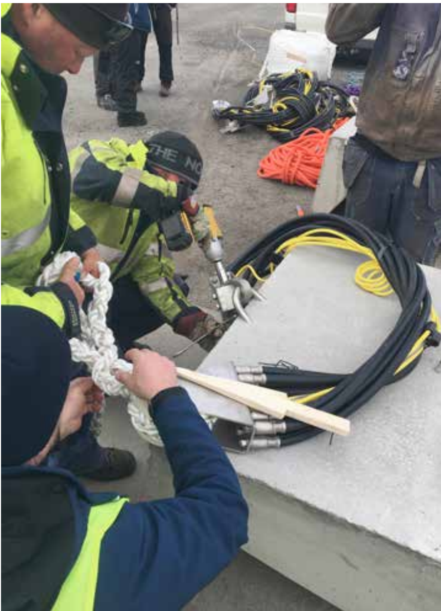
Her er man ved at montere Seaflex på flydebroerne før søsætning.
